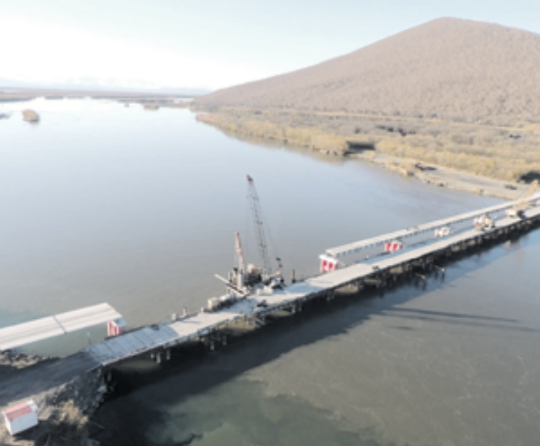
▲ Строительство моста через р. Камчатка, трасса Мильково – Ключи – Усть-Камчатск.
