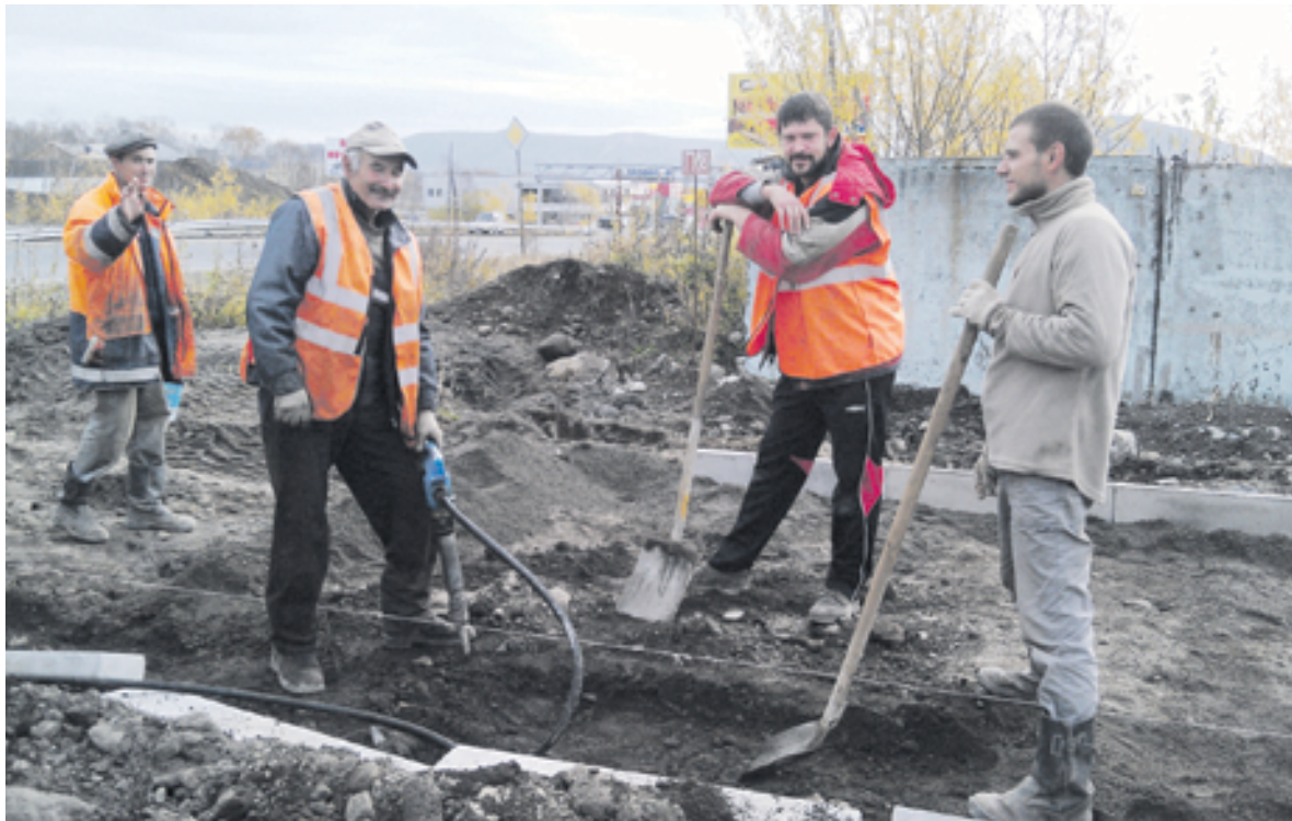
< Бригада рабочих МУП «Спецдорремстрой» на сдаточном объекте, ул. Вулканная.
