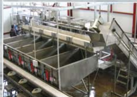
СОРТИРОВОЧНЫЙ УЧАСТОК ЗАВОДА ПО РЫБОПЕРЕРАБОТКЕ
