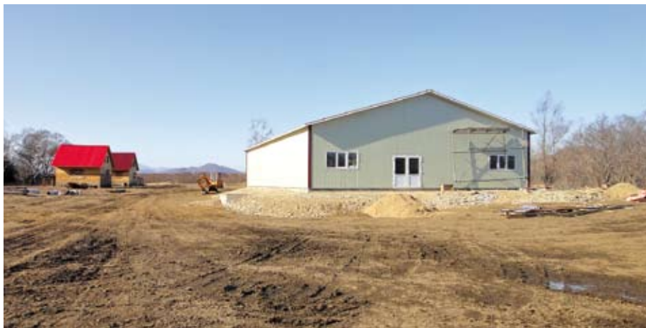
Здание нового частного завода на р. Вербная, Ольгинского района Приморского края (строительство продолжается)
