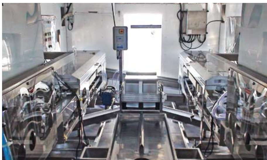
Сразу две линии NAG-501 смонтированы в ограниченном пространстве на судне одного из крупных дальневосточных предприятий
