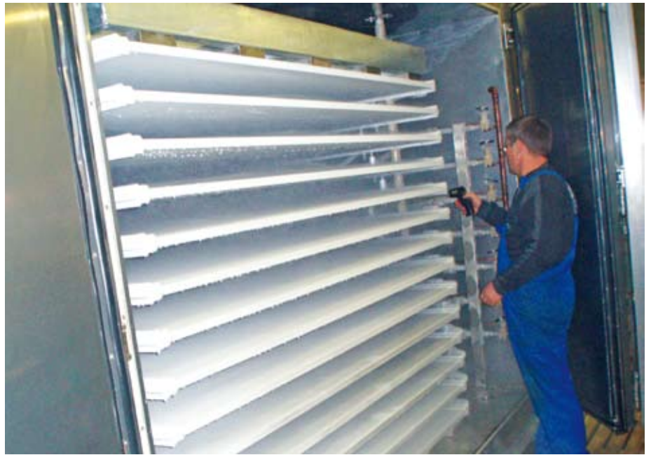
Пусконаладка скороморозильного плиточного аппарата контактной заморозки
