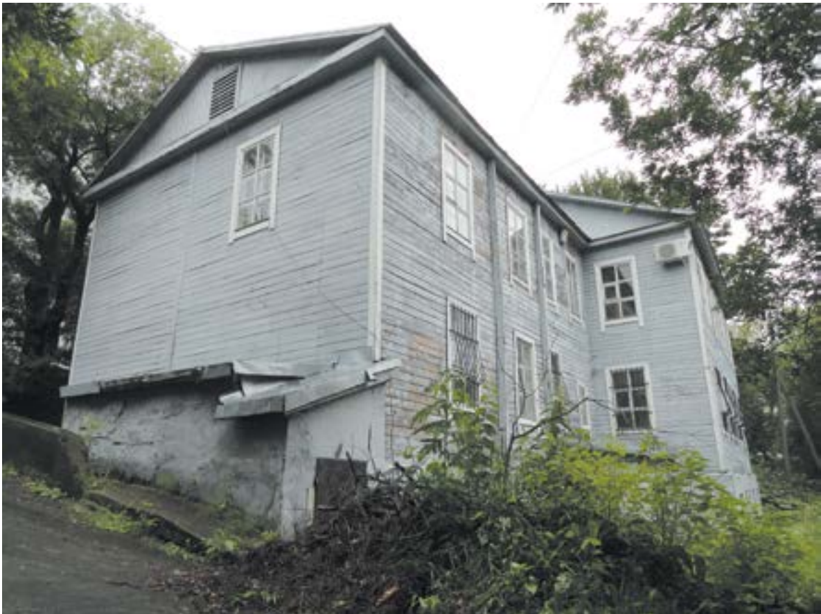
▲ В этом 2-этажном деревянном здании на ул. Партизанская Камчатрыбвод ютился до конца 1990-х
